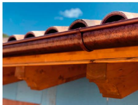
La grondaia Artegronda è molto robusta, non si deforma a seguito degli sbalzi termici e non si flette sotto il peso di acqua, neve e grandine. Sopporta senza problemi l'appoggio di una scala (per essere pulita o per l'accesso al tetto).
