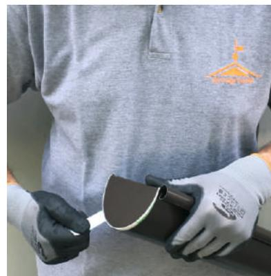
La testata terminale ha una speciale banda adesiva siliconica già applicata che, oltre ad unirla saldamente alla grondaia, garantisce sin da subito una perfetta sigillatura.
